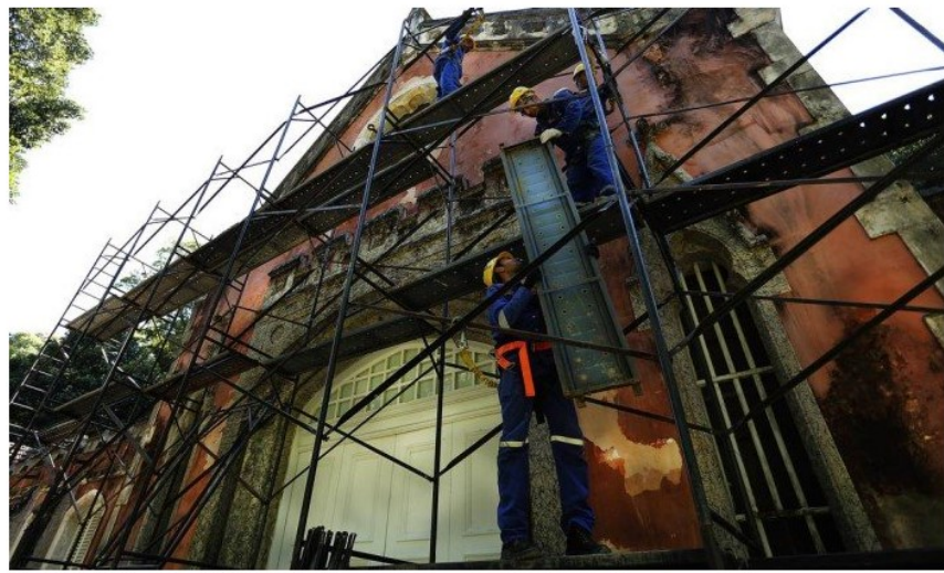
Operários trabalham em reforma do conjunto de prédios históricos do Parque Lage , na Zona Sul do Rio (Foto: Agência O Globo)
